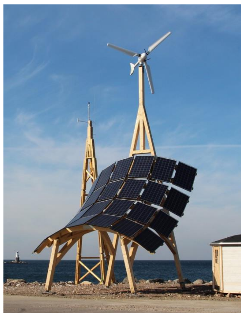
Figure 265. La Girafe de l'entreprise suédoise Innoventrum, un dispositif hybride de production d'énergie éolien et photovoltaïque créant aussi un carport
