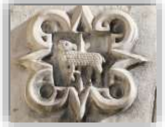
→ Ci-dessus : photographie 96. Linteau d'une maison de Laruns.
