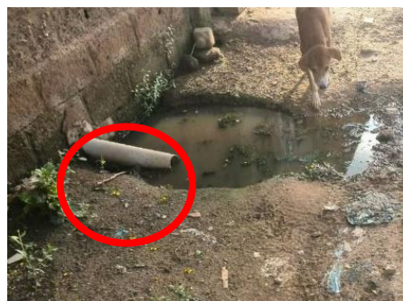
Photographie I-5 : Exemples d'incivilité à Ouagadougou par connexion de conduite d'évacuation d'eaux vannes directement dans un canal (a-) et dans la rue (b-)
