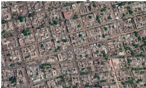
a- Construction en zone planifiée avec un tracé rectiligne
