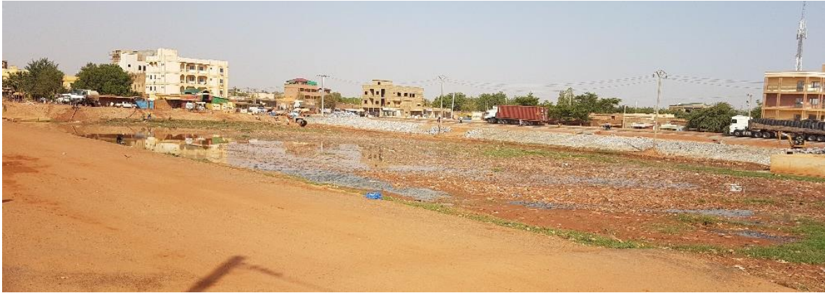
Photographie IV-3 : Exemple d'un bassin de rétention d'eau en fonctionnement jouxtant le boulevard des Tensoba à Ouagadougou
