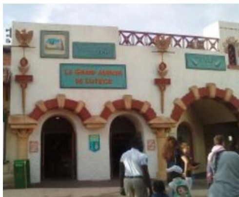
Figure 35 Photographie de la façade du Marché de Lutèce au Parc Astérix (photographie prise par l'auteur le 13/06/2017)
