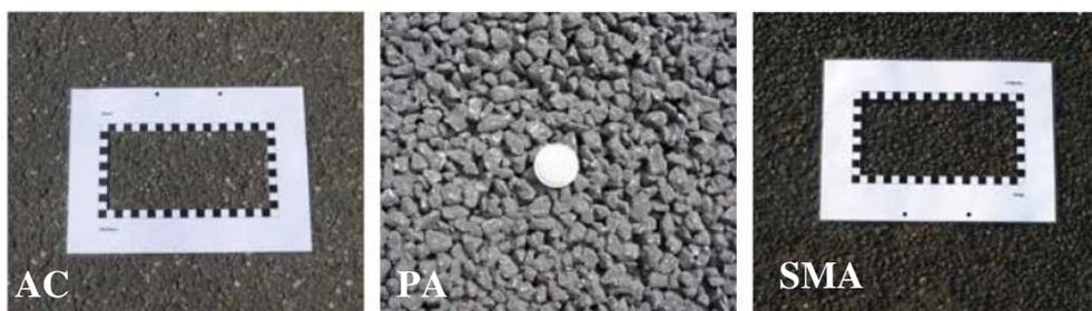
Figure 6 : Exemples de différents types de revêtements bitumineux
