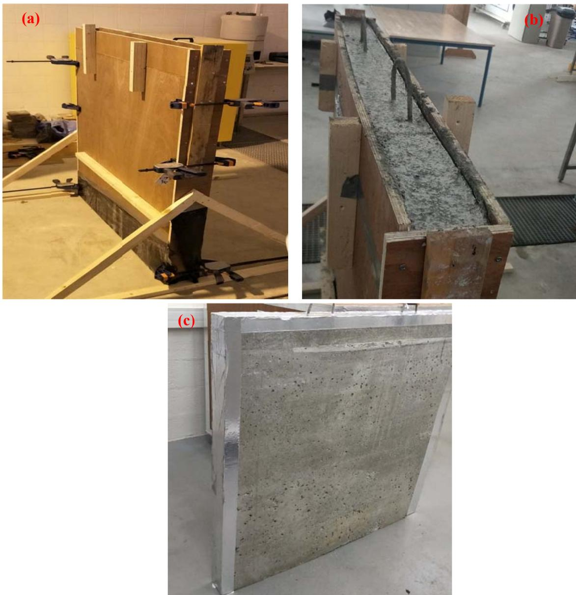
Figure V- 3 : La mise en œuvre de la paroi. (a) le coffrage, (b) le coulage, (c) la paroi après décoffrage.
