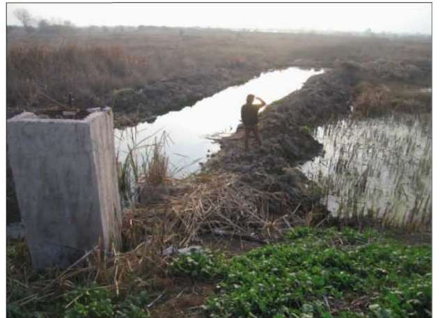
c. Canal d'alimentation de la zone humide depuis la station d'épuration Batuco, Lampa
