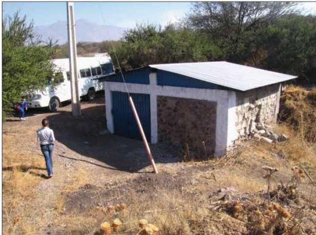
b. L'une des 5 stations de pompage du Fundo La Laguna , Batuco, Lampa
