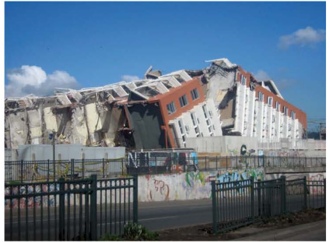
b. La tour Alto Río après le tremblement de terre du 27 février 2010
