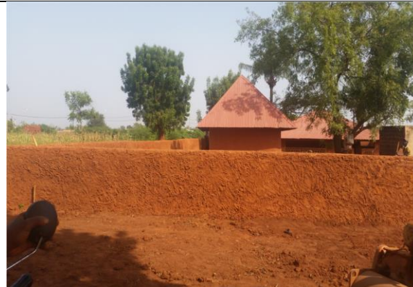
Figure I.6 : Construction d'une clôture en bauge au Bénin (Photo ADAGBE M.)
