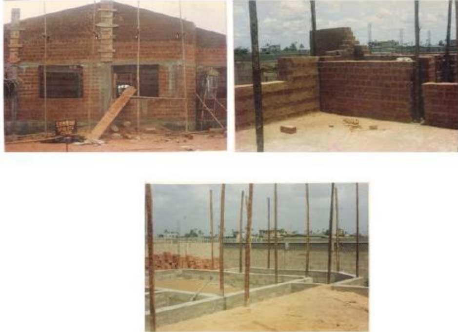
Figure I.17 : Utilisation du bois rônier pour la construction d'une villa en terre de barre stabilisée (KOUKOUBOU, 2017)
