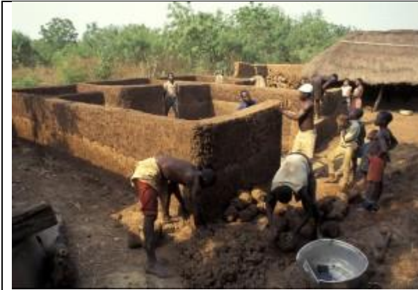
Figure I.5 : Construction d'une maison en bauge au Bénin (PERELLO, 2015)
