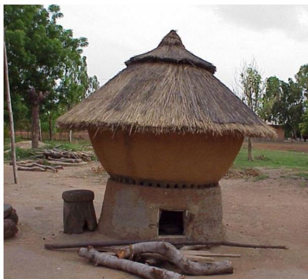
Figure I.12 : Greniers en banco du nord-ouest du Bénin construit avec de l'adobe stabilisé par les fibres de tiges de riz (Cliché GIBIGAYE)
