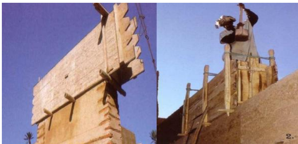
Figure I.7 : Coffrage et compactage des murs en pisé (MAKRI et al., 2000)
