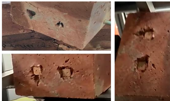
Figure IV.21: Glissement des armatures
