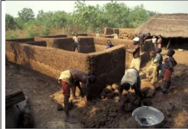
Figure I.5 : Construction d'une maison en bauge au Bénin (PERELLO, 2015)
