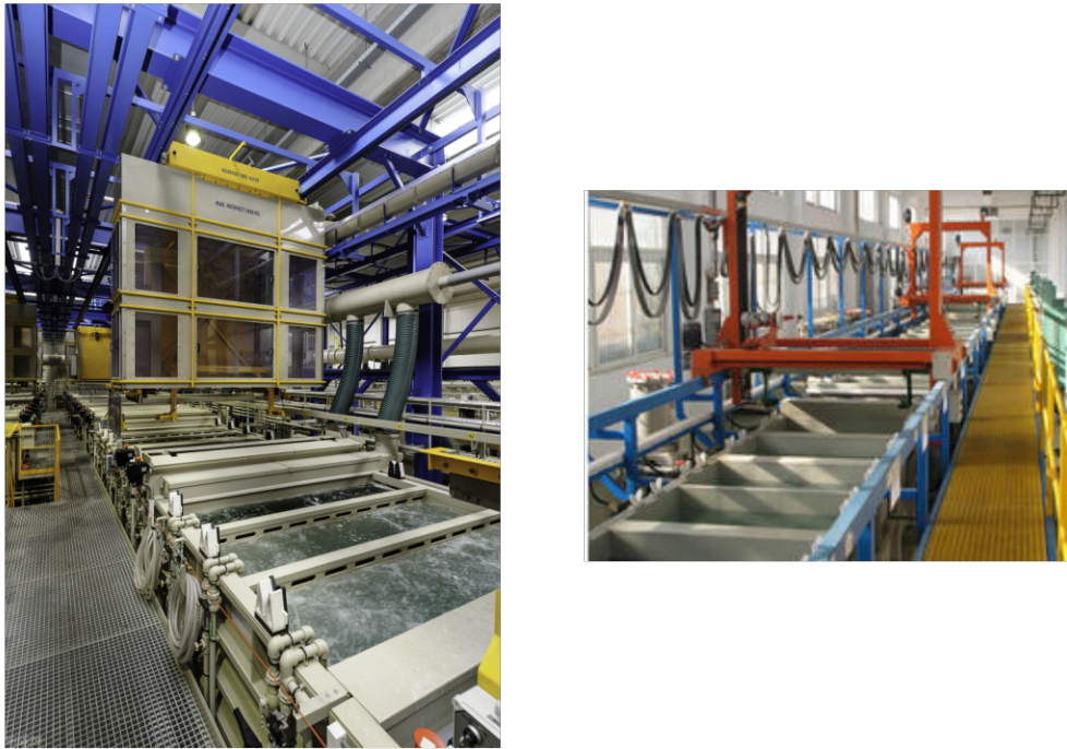
FIGURE 1.6 – Ateliers de traitement de surface.
