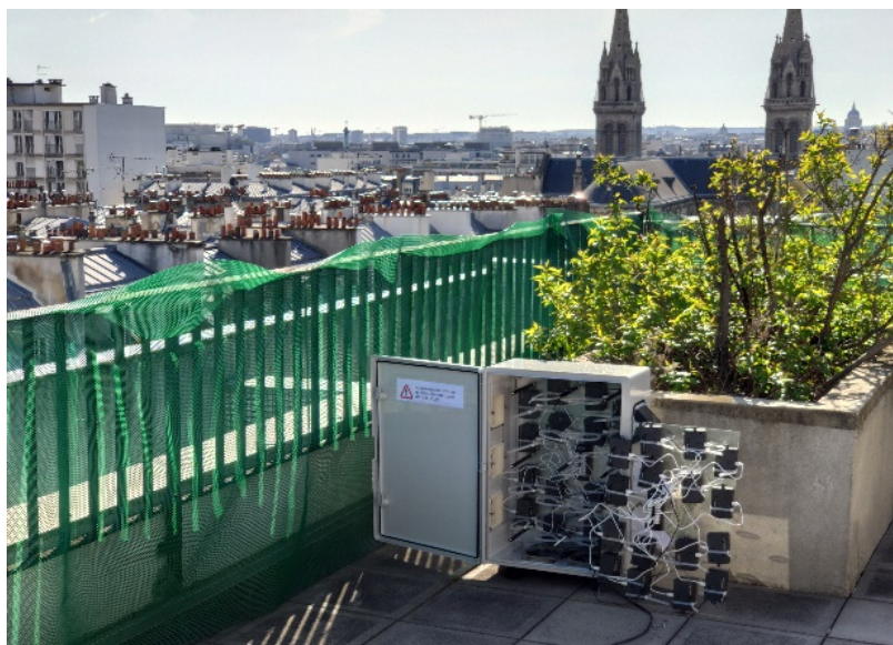
FIGURE 35 : Environnement de test en extérieur (3 ème )
