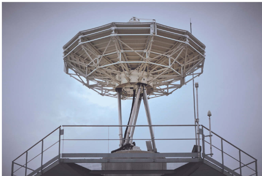
FIGURE 3 : Antenne de la Maison de la Télédétection
