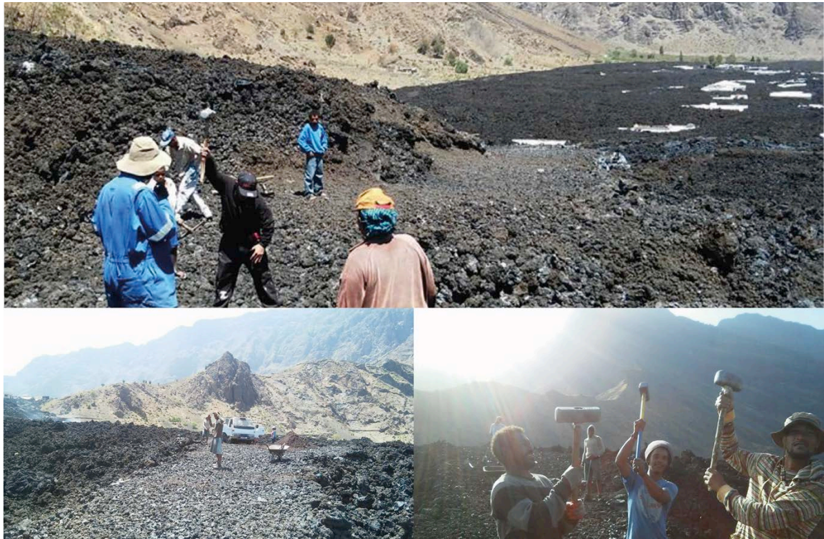
Figure 8.8. Reconstruction communautaire de la route au niveau de la jonction entre Portela et Bangaeira (Pedro Danilo Fontes, avril 2016 ;), et à Bangaeira (Pedro Danilo Fontes, 28 mars 2017).
