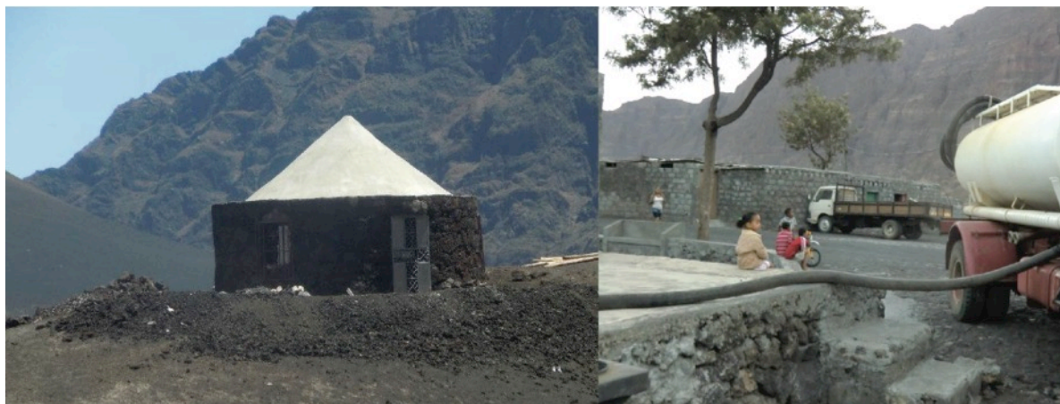
Figure 1.22. Récupération de l'eau de pluie avec les toits des maisons et approvisionnement par camion-citerne (Chourraqui, 2011).
