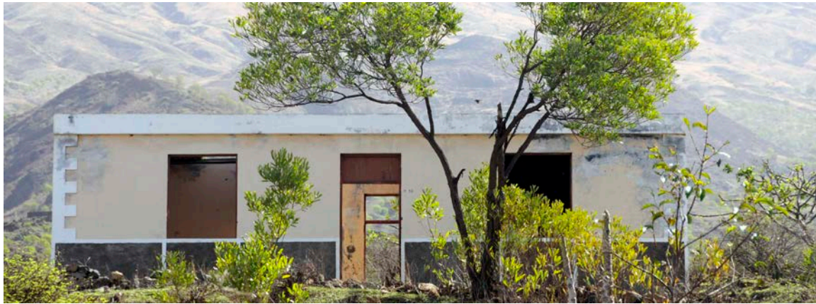
Figure 6.8. Maison de relogement abandonnée à Monte Grande (Chourraqui, été 2012)
