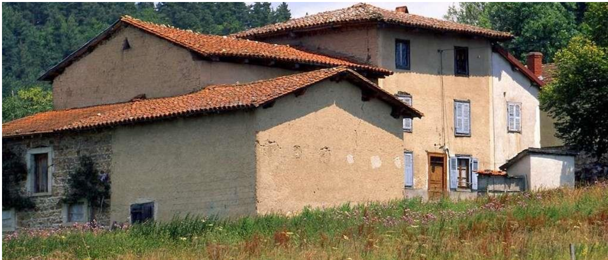
Figure 0.2 - Exemple de construction en pisé dans les environs de Marsac-en-Livradois, Puy-de-Dôme ( Parc Naturel Régional Livradois-Forez , 2015).
