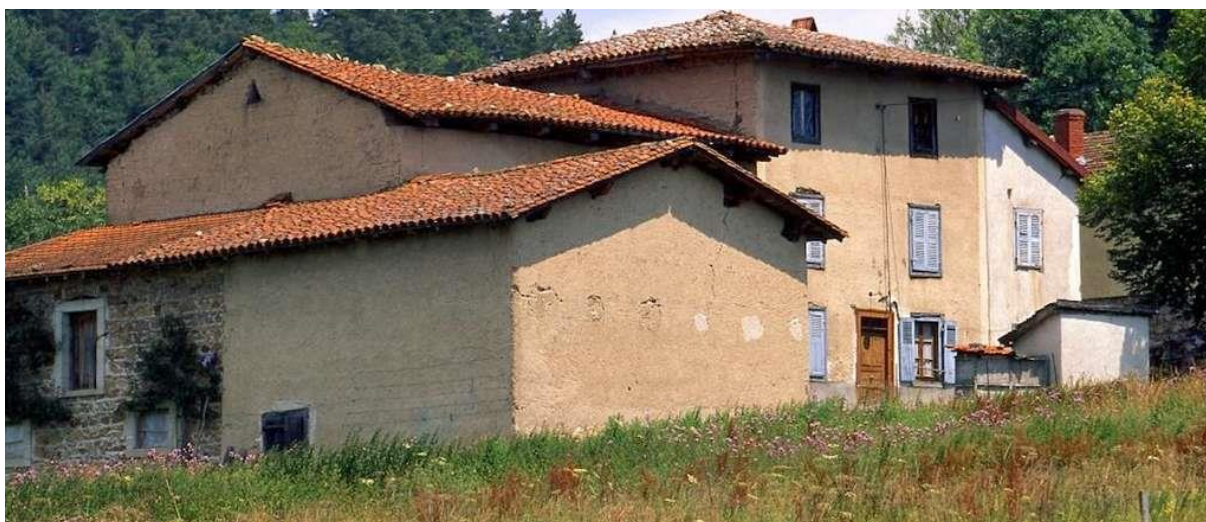
Figure 0.2 - Exemple de construction en pisé dans les environs de Marsac-en-Livradois, Puy-de-Dôme ( Parc Naturel Régional Livradois-Forez , 2015).
