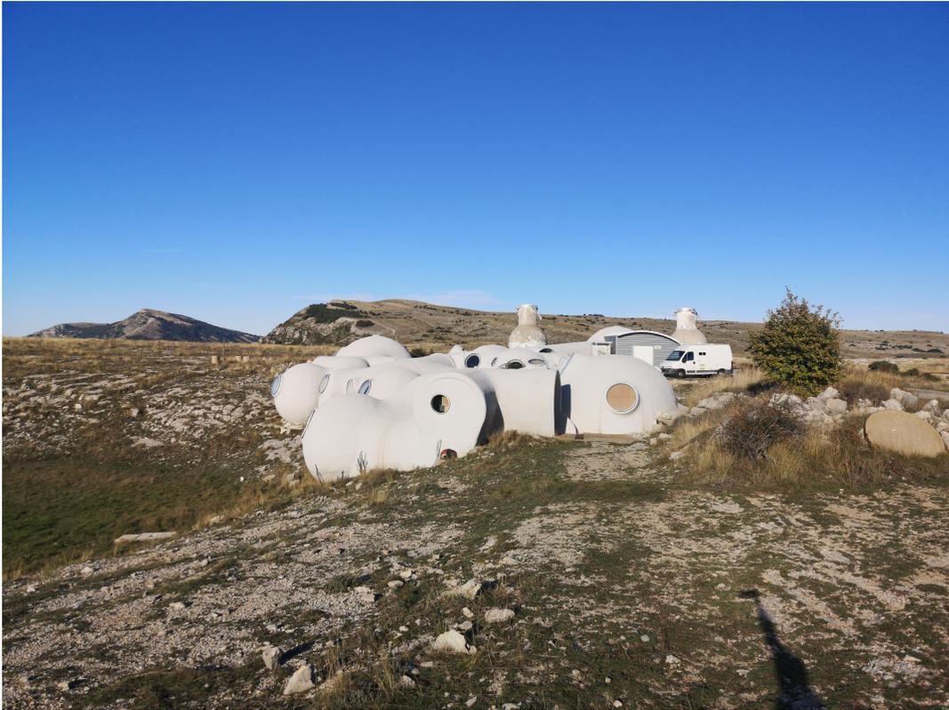
FIGURE 1.5: Photo personnelle du Grand Interféromètre à deux Télescopes (GI2T), que j'ai prise sur le plateau d'observations de Calern, à l'Observatoire de la Côte d'Azur, en octobre 2019 lors de séances d'observations réalisées dans le cadre de ma thèse. On remarque les deux télescopes montés sur des rails coulissants qui permettaient autrefois de régler la distance de la base séparant les deux télescopes.
