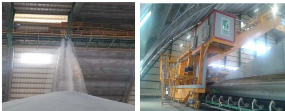
Figure 1. 9- Stockage et reprise des produits stockés en vrac dans un Hangar.
