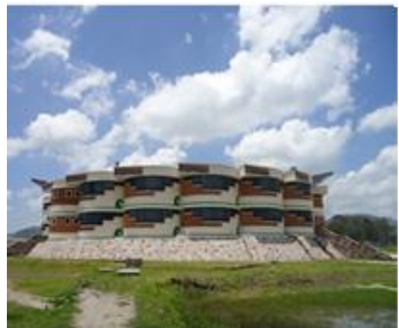
Figure 23 Bâtiment principal de l'Université Interculturelle de l'État de Mexico, connu comme Quetzalcóatl (Le serpent à plumes). Photographie de novembre 2012. Archives personnelles.
