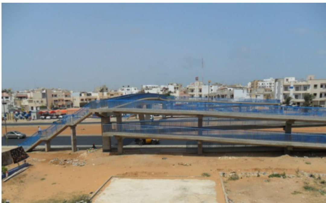
Photo 2 : Passerelle sur la voie de dégagement Nord avec une grande rampe pour PMR
