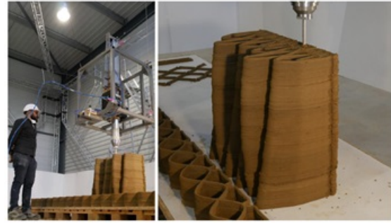
FIGURE 1.9 – Construction en argile avec Cogiro [Izard et al. (2017, 2018); Dubor et al. (2018)]
