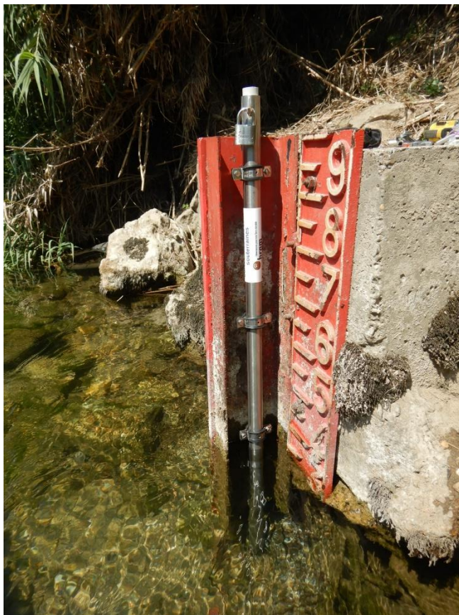
Figure 2.5 : Installation d'un dispositif de mesure de conductivité électrique sur la Cèze (05/07/2019).
