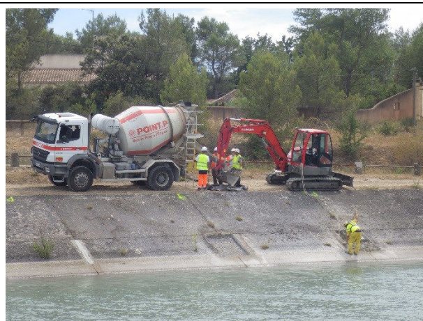
Photo 4 : Passage d'engins lourds et polluants sur la piste d'un canal lors de travaux de dessouchage. Création de nouveaux joints sur les zones réparées (Photo : Macia J., 2015).
