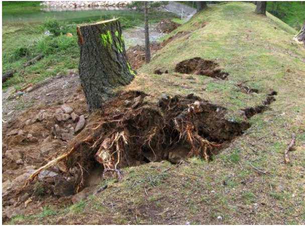
Photo I. 3 : Soulèvement et destruction d'une digue suite au développement du système racinaire et au basculement d'un arbre (Photo : Zanetti C., 2010).
