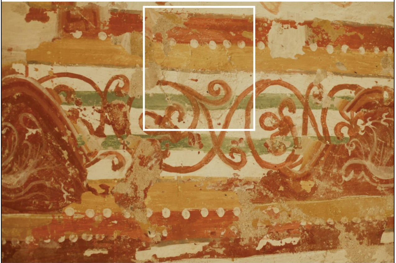
Photographie du trou de boulin bouché, photographie localisée par un rectangle noir sur le relevé
