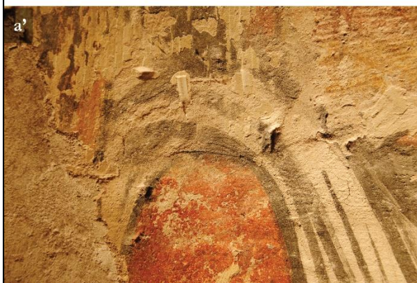
Fig. 39 : Photographies d'incisions dans le badigeon
