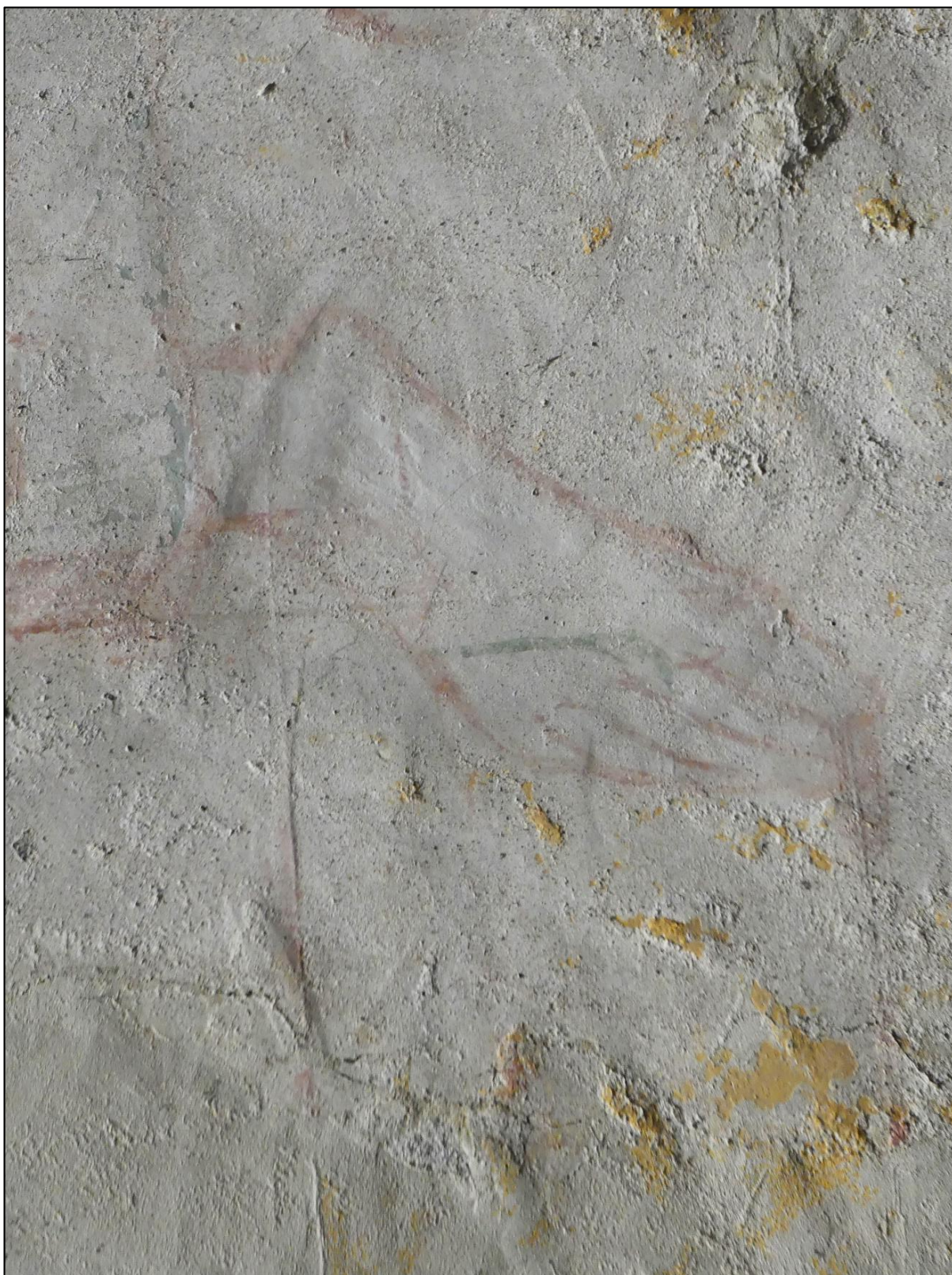
Fig. 31 : Photographie du cordeau et des incisions pour déterminer l'emplacement des pieds, Parçay-Meslay, église Saint-Pierre (campagne 2)
