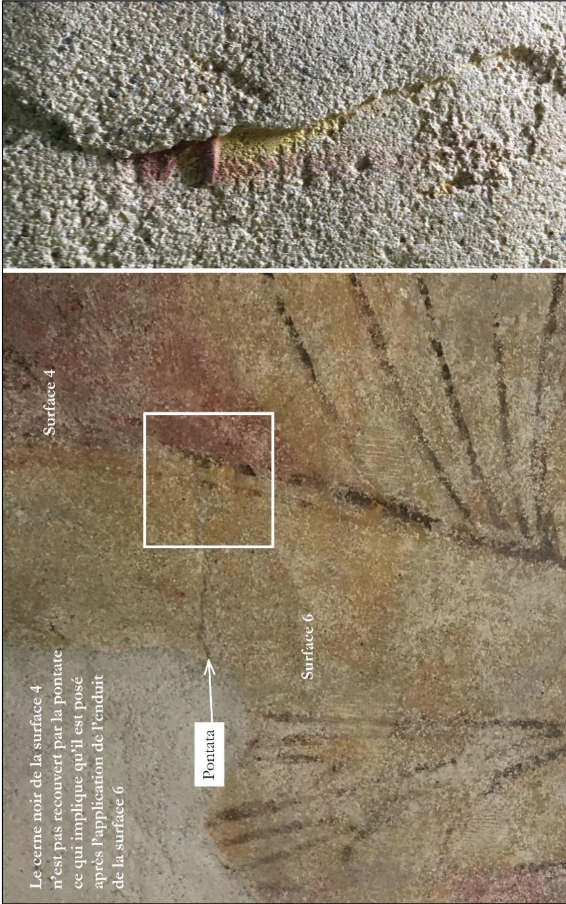
Fig. 61 : Photographies de deux raccords d'enduit avec des traces de peinture, Rivière, église Notre-Dame (campagne 1)
