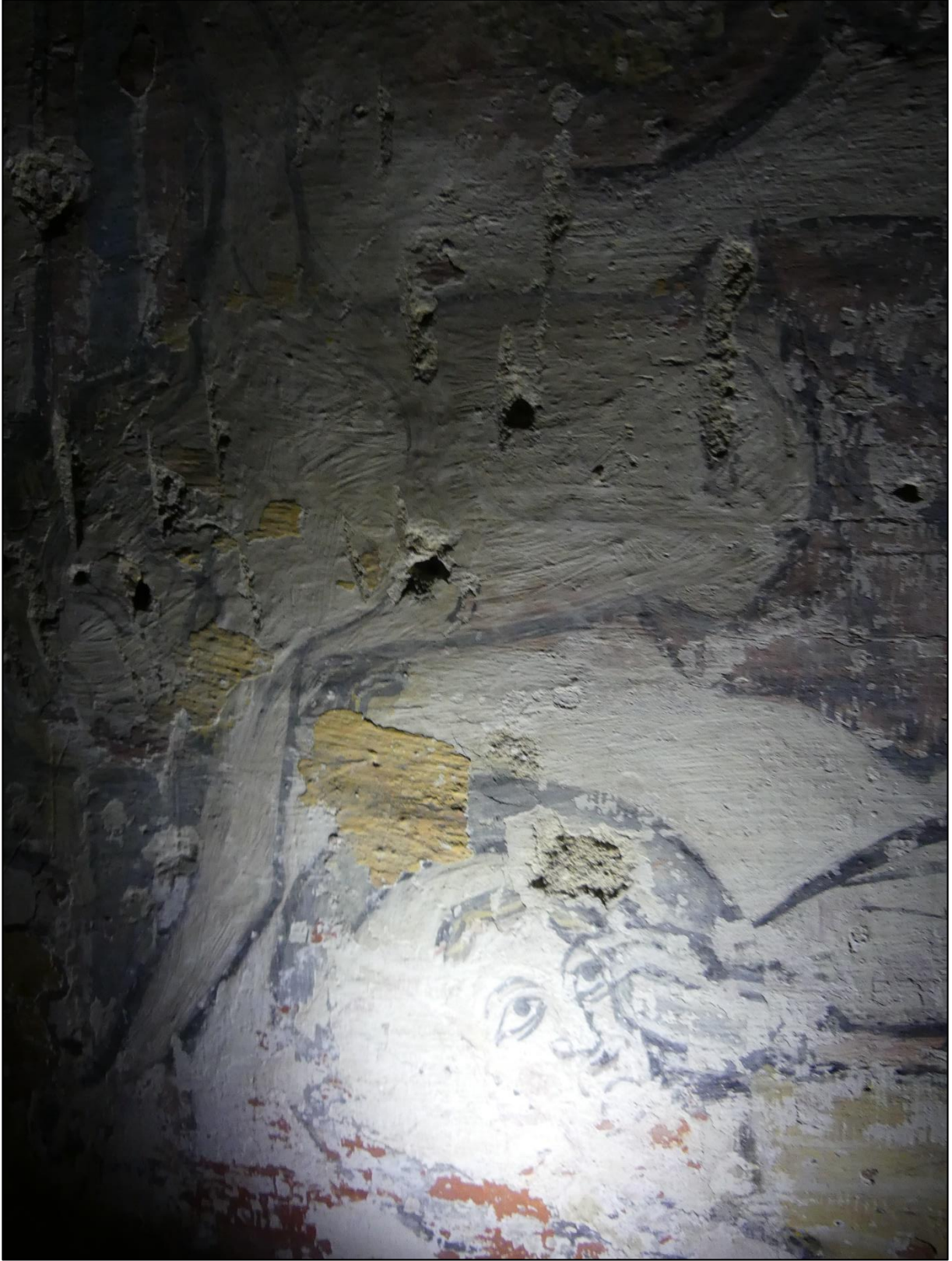
Fig. 63 : Photographie des traces de brosses dans le badigeon et dans la couche picturale, Sorigny, église Saint-Pierre-ès-Liens (campagne 1)
