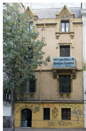
Le bâtiment aujourd'hui
