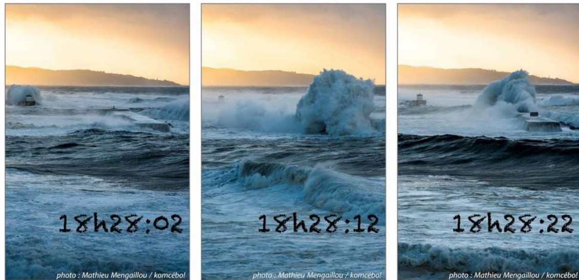
FIGURE 3.4 Photo du 28 février 2017 montrant une vague déposant un bloc de 50 tonnes sur la digue de l'Artha [78].
