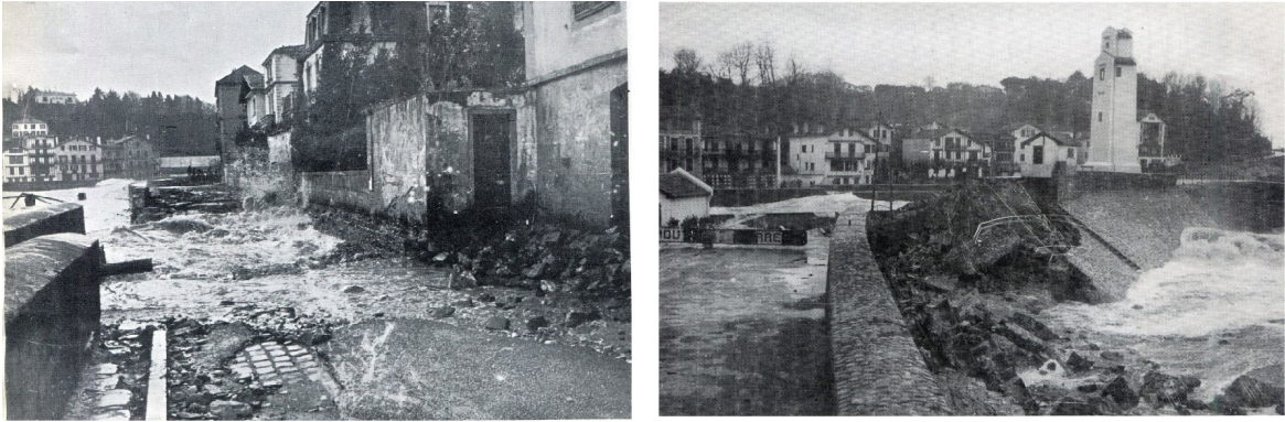
FIGURE 3.2 Photos de 1951 montrant les dégâts de la tempête à Saint-Jean-de-Luz [77].
