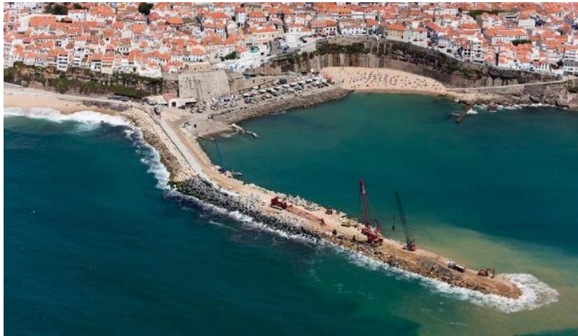
FIGURE 1.9 Exemple d'un brise-lame en reconstruction [19].
