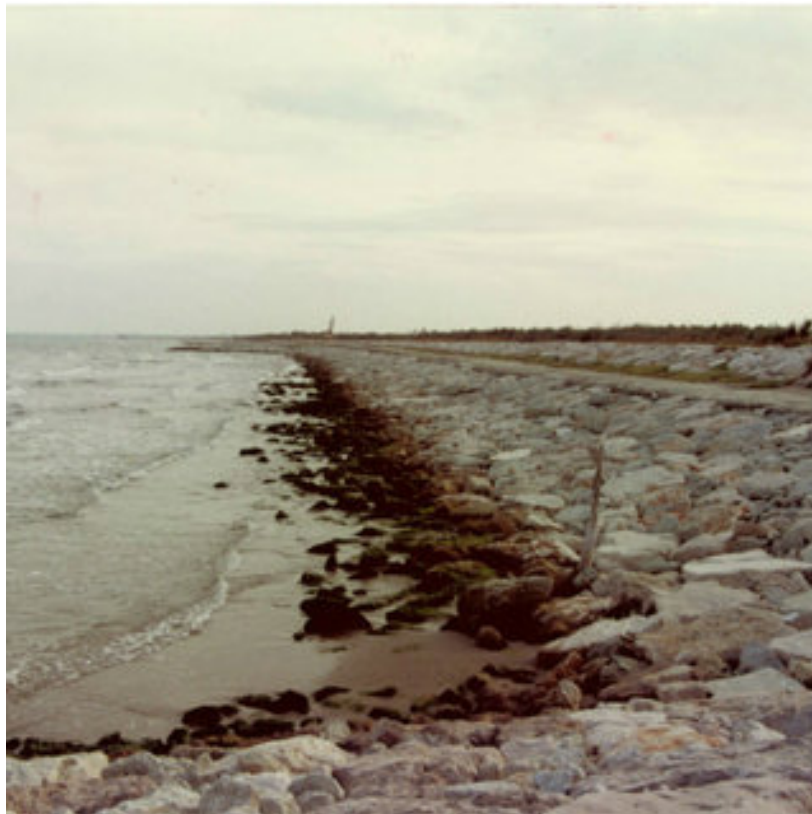
FIGURE 1.8 Exemple d'une digue sur une plage [17].
