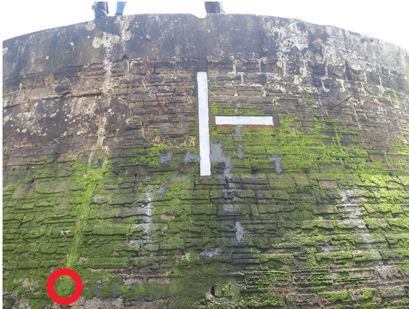
FIGURE 3.9 Photo rapprochée du mur avec les capteurs. Le capteur 0 est entouré en rouge.
