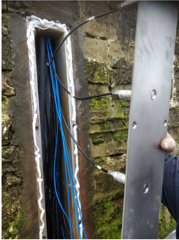
FIGURE C.9 Mise en place de la plaque verticale de capteurs.
