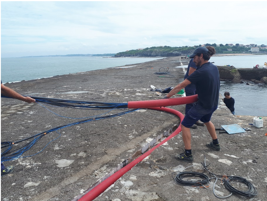
FIGURE C.5 Photo de la mise en place de la gaine et tirage des câbles des capteurs.
