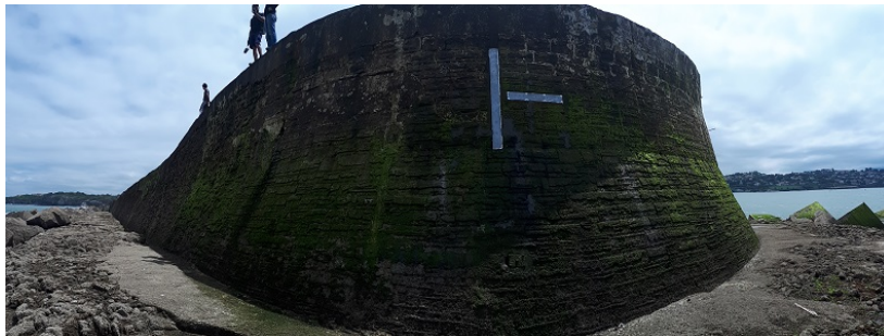
FIGURE 3.10 Photo panoramique du musoir ouest avec les capteurs.
