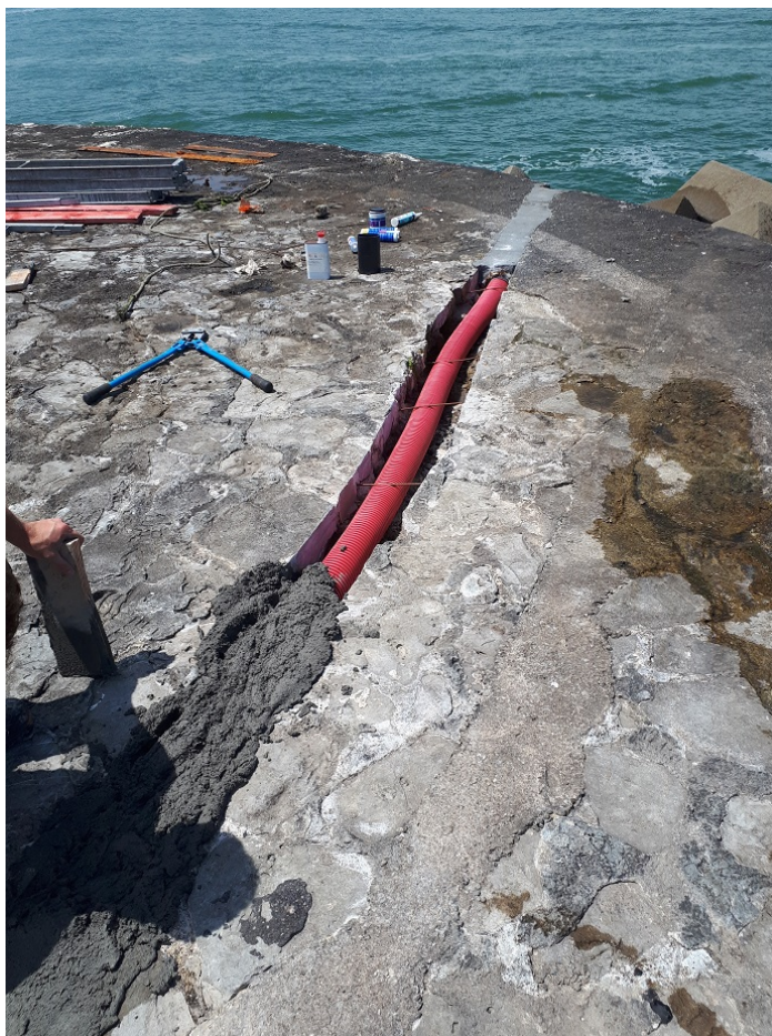
FIGURE C.6 Coulage du béton sur la gaine électrique où passent les câbles des capteurs.
