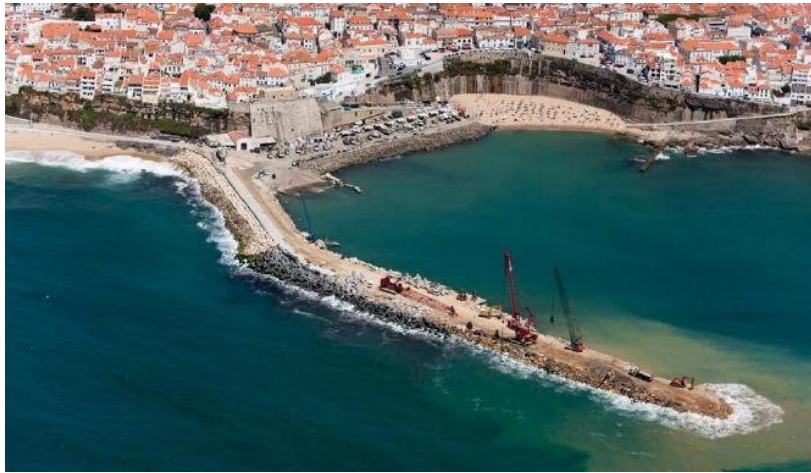
FIGURE 1.9 Exemple d'un brise-lame en reconstruction [19].
