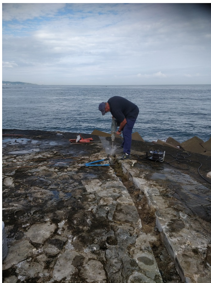
FIGURE C.1 Photo d'un agent du CD64 en train de réaliser la saignée sur la digue à l'aide d'un marteau piqueur.
