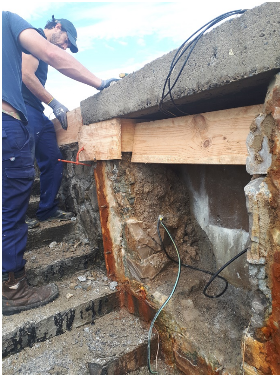
FIGURE C.2 Photo de deux agents du CD64 en train de remettre en état l'endroit où sera placé la station.
