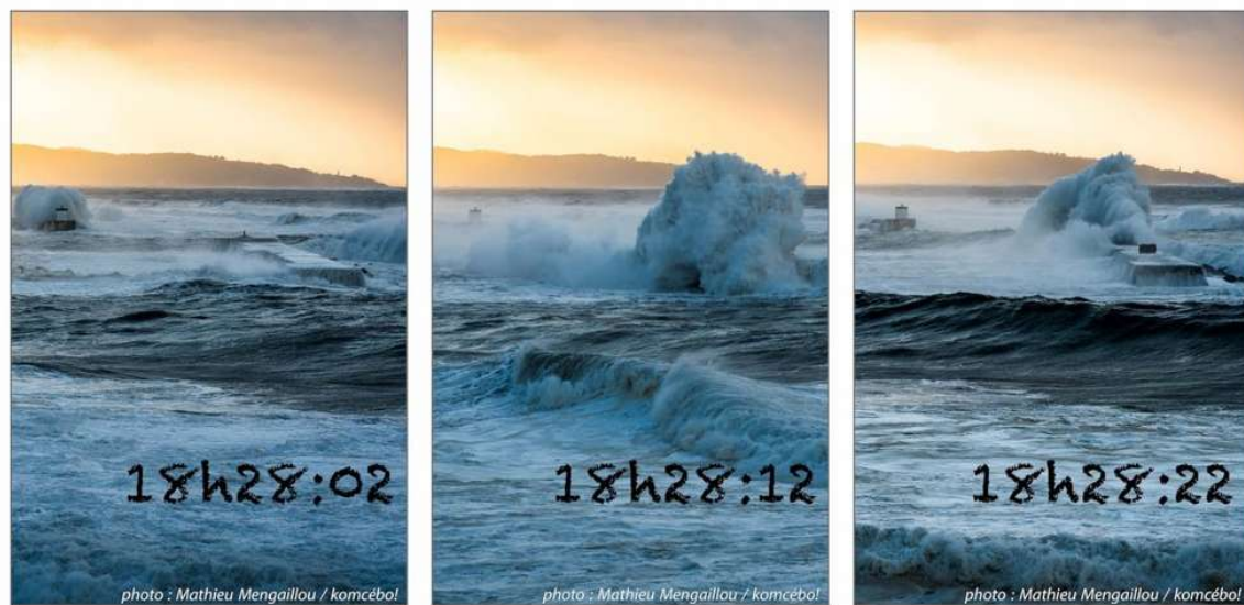
FIGURE 3.4 Photo du 28 février 2017 montrant une vague déposant un bloc de 50 tonnes sur la digue de l'Artha [78].
