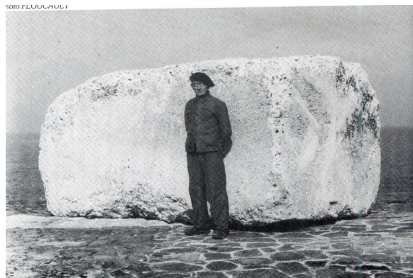
FIGURE 3.3 Photo de 1951 montrant un bloc de 40 tonnes sur la digue [77].
