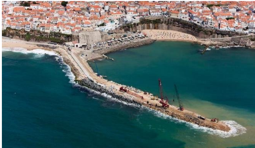
FIGURE 1.9 Exemple d'un brise-lame en reconstruction [19].
