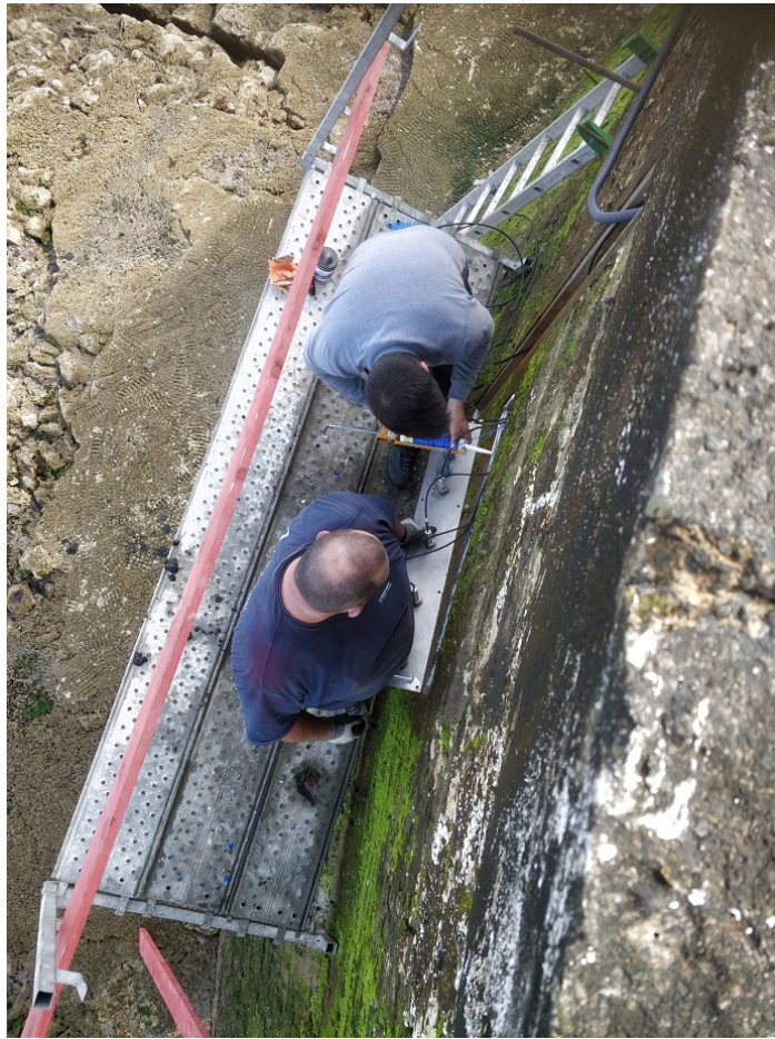
FIGURE C.7 Mise en place de la plaque horizontale de capteurs, vue de haut.
