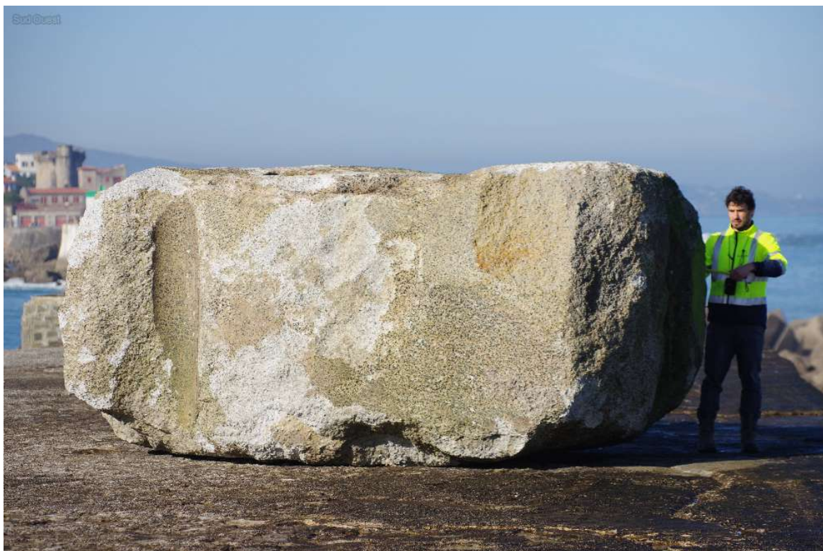
FIGURE 3.5 Photo de mars 2017 montrant le bloc de 50 tonnes sur la digue de l'Artha [78].
