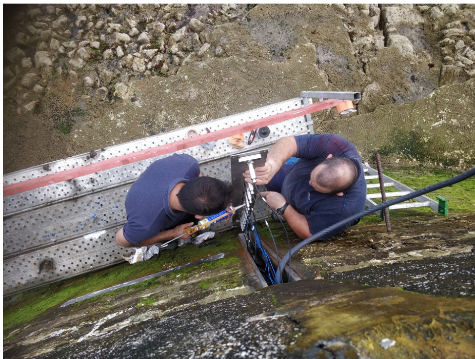
FIGURE C.8 Mise en place de la plaque verticale de capteurs, vue de haut.
