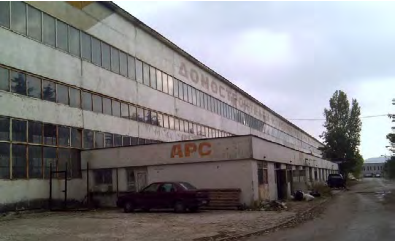
L'usine de préfabrication de Varna aujourd'hui
