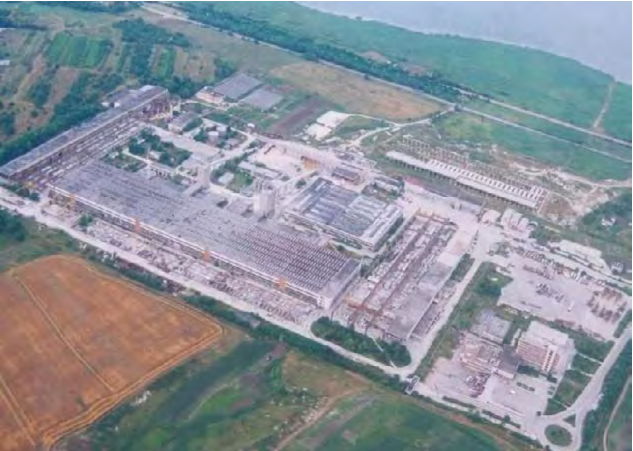
L'usine de préfabrication de Varna sur les bords du lac dans les années 70
