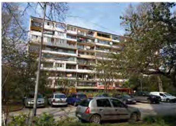
Façades sud de la typologie
