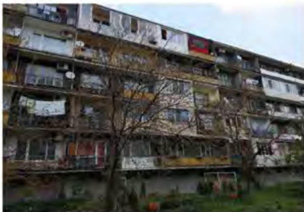
Façades sud de la typologie
