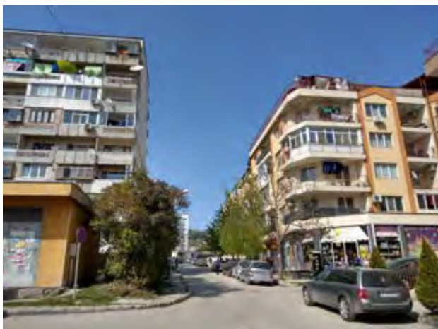
Des opérations contemporaines jouxtant les préfabriqués communistes
