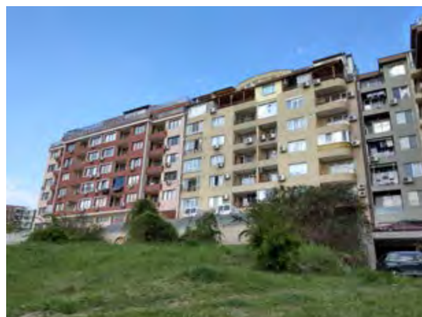
De nouvelles opérations en périphérie
