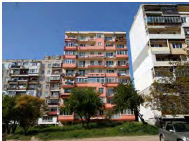
Un immeuble rénové à Mladost 2
