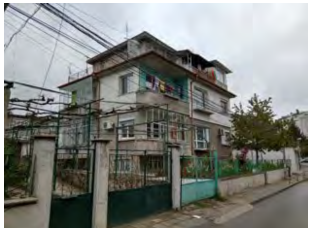
Une variété d'appropriations en façade
