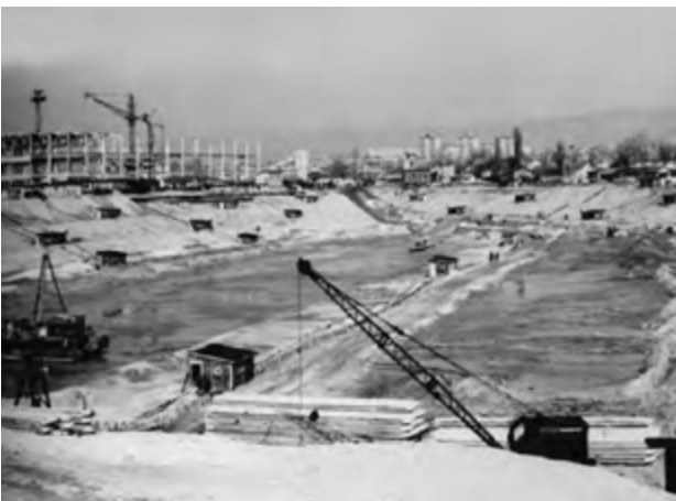
La construction des cales sèches lors de la modernisation du port principal au cour des années 50
