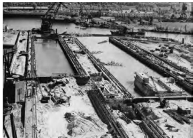
La construction des cales sèches lors de la modernisation du port principal au cour des années 50
