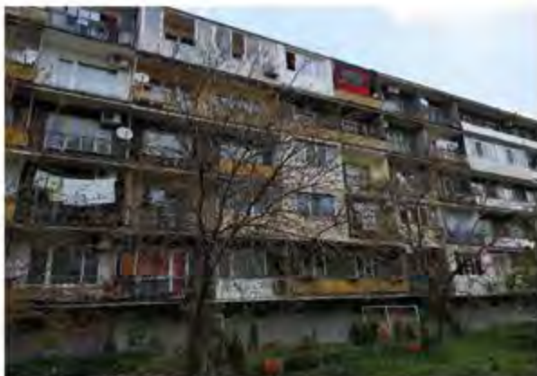
Façades sud de la typologie
