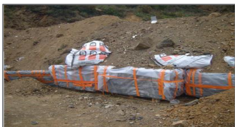
Figure 50 : La couverture des déchets amiantés en alvéole
