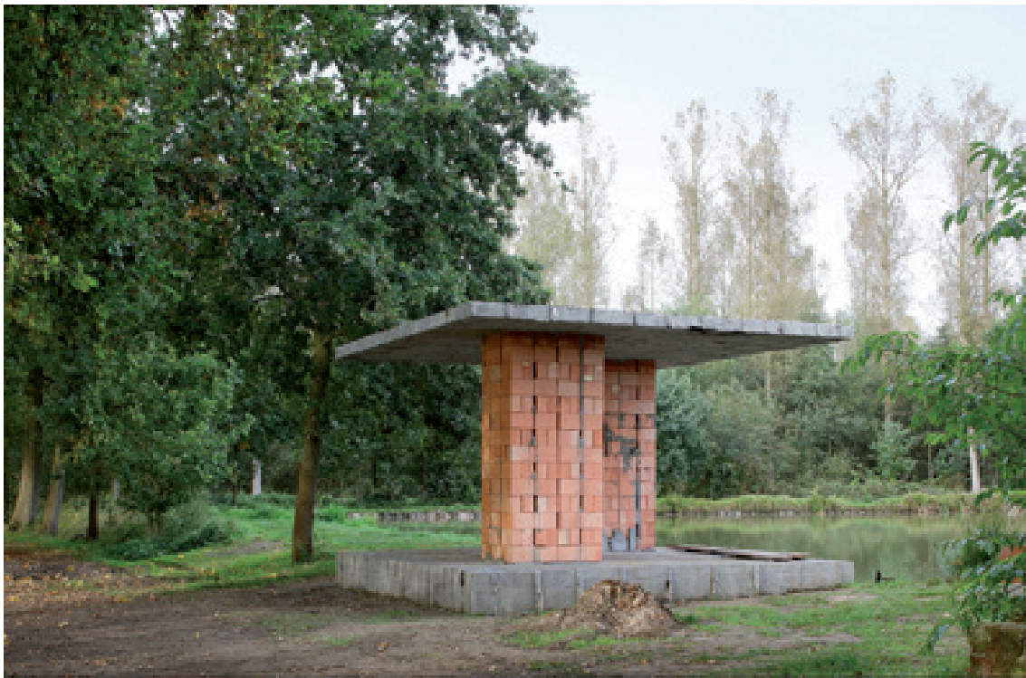
ILLUSTRATION 36 — Podium Pile Pavilion, Architecten De Vylder Vinck Taillieu, Horst, Belgique, 2017, © Filip Dujardin.
