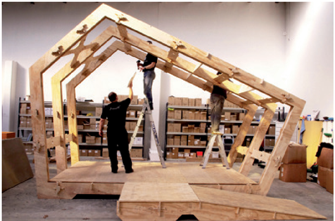
ILLUSTRATION 6 — Construction d'une maison Wikihouse , © Wikihouse.
