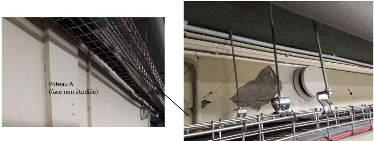
FIGURE 4.10 – Fissure longitudinale visible de l'autre côté du poteau de l'essai A en haut de celui-ci.
