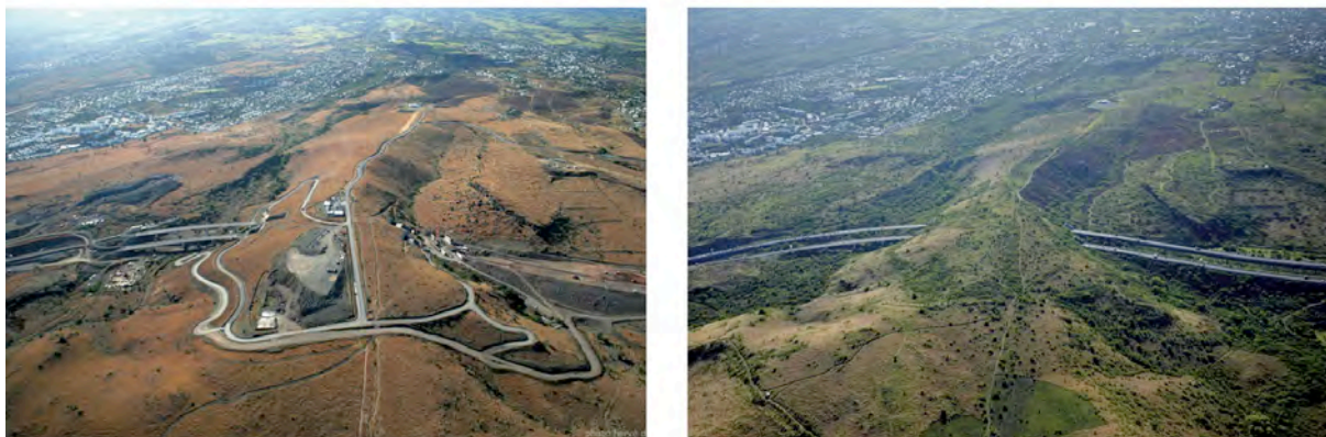
Figure III. 31 : Photocomparaison, vue sur l'amont des ravines Fleurimont et Boucan Canot dans le secteur du cap La Houssaye.
