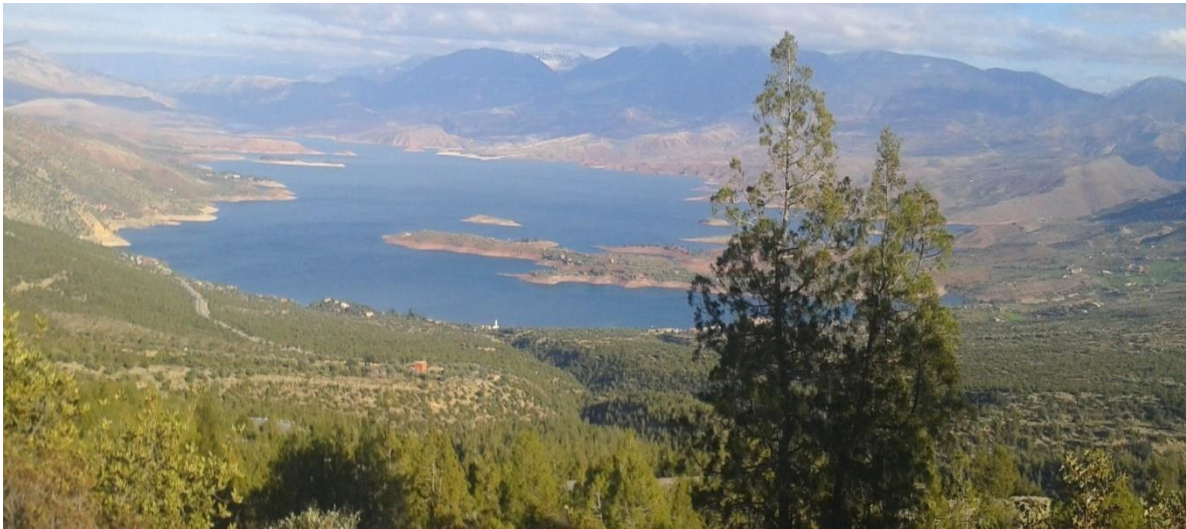
Figure 21: Vue panoramique du barrage Bin El Ouidane
