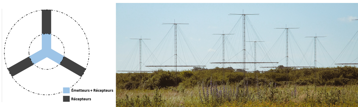
FIGURE 1.4 – Géométrie du réseau d'antennes et antennes bicônes utilisées pour le radar NOSTRADAMUS
