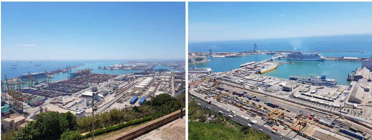
FIGURE 3.13 – Port de Barcelone et infrastructures multimodales (Julien Le Van Suu 10/05/2019)
