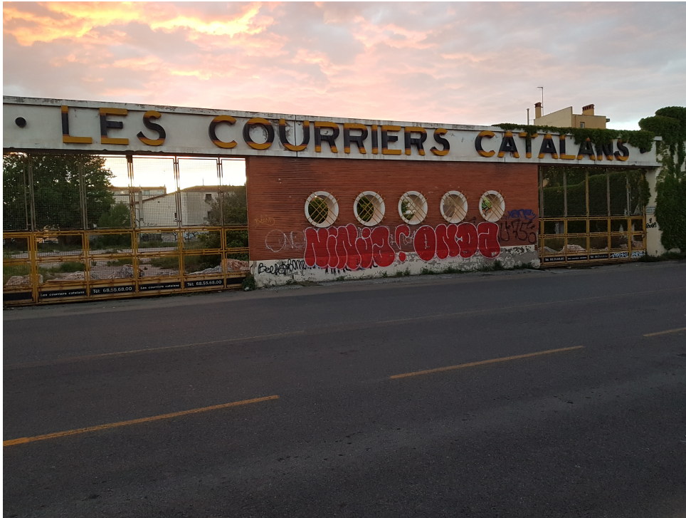
FIGURE 2.9 – Une friche industrielle à proximité de la nouvelle gare : Les courriers catalans (Julien Le Van Suu 04/25/2019)
