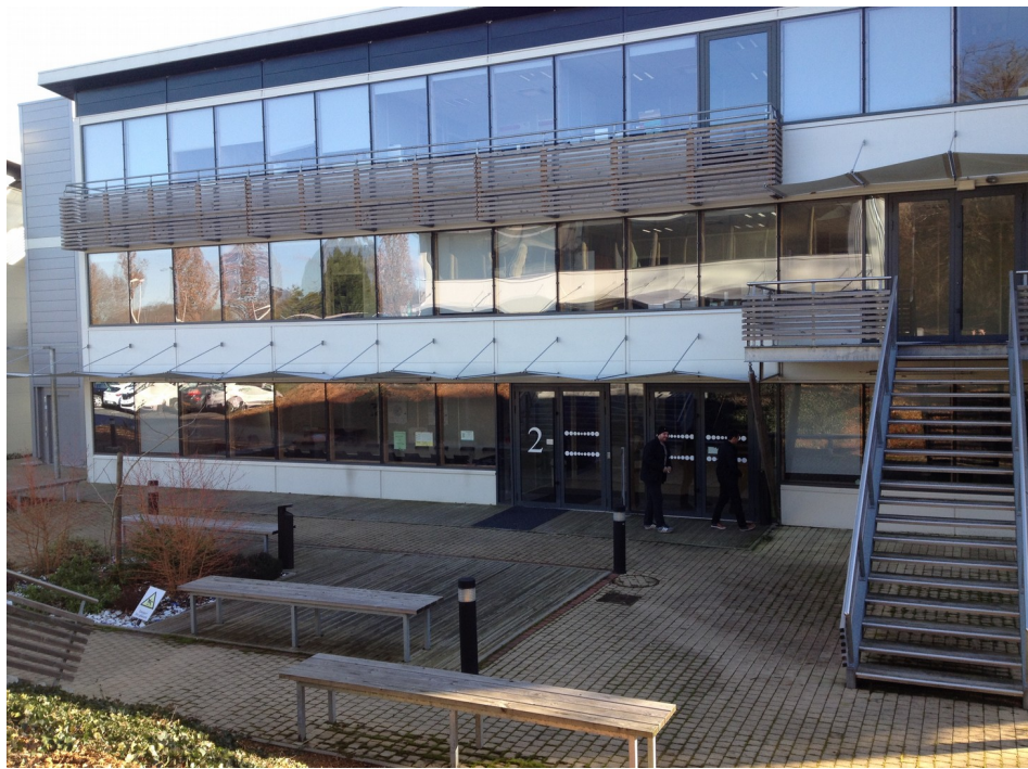
Illustration 13 : Bâtiment principal du pôle Élopsys
