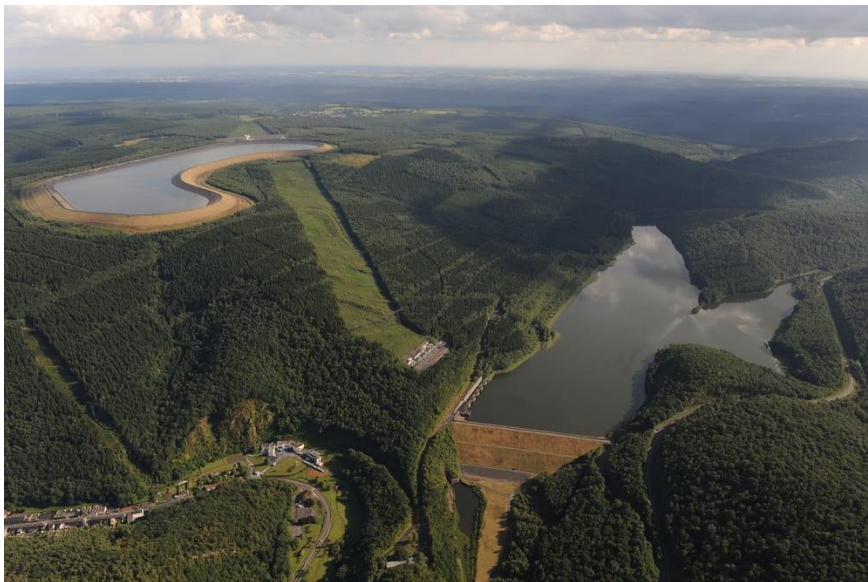
Figure 2-5. Centrale de Revin (Source : EDF)
