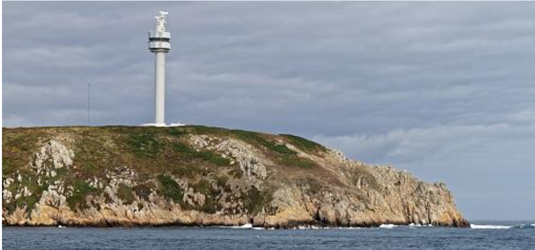
FIGURE 19. CENTRE DE SURVEILLANCE DU TRAFIC - SEMAPHORE DU STIFF, OUessant. CREDIT : CHROMOPRISME.
