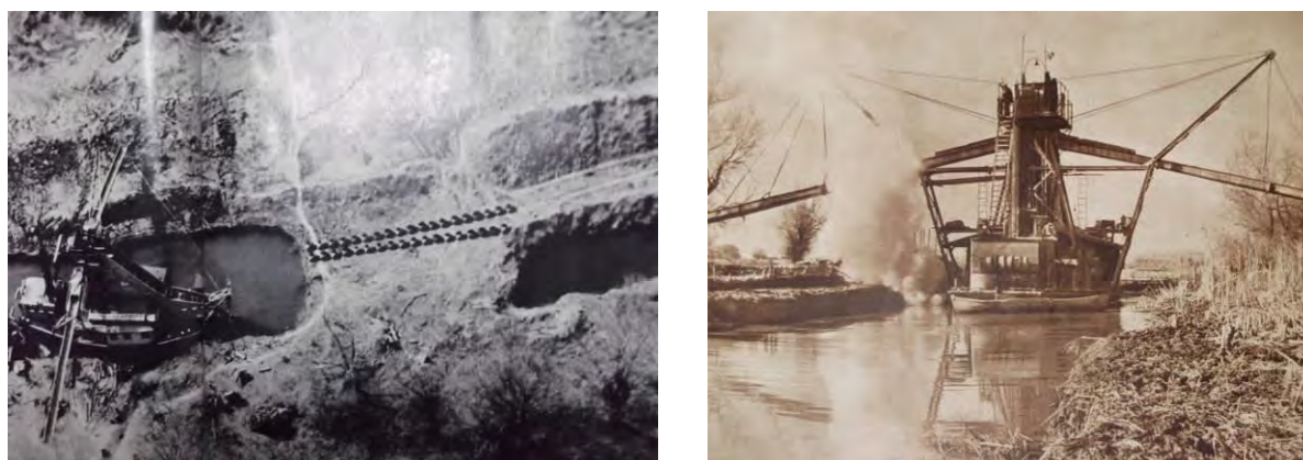
Fig.13.17 Le creusement des canaux dans le delta avec des dragues
