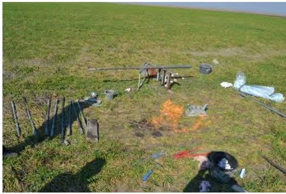
a. Photo site carottage
