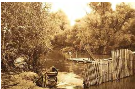
a. Clôture sur un canal
