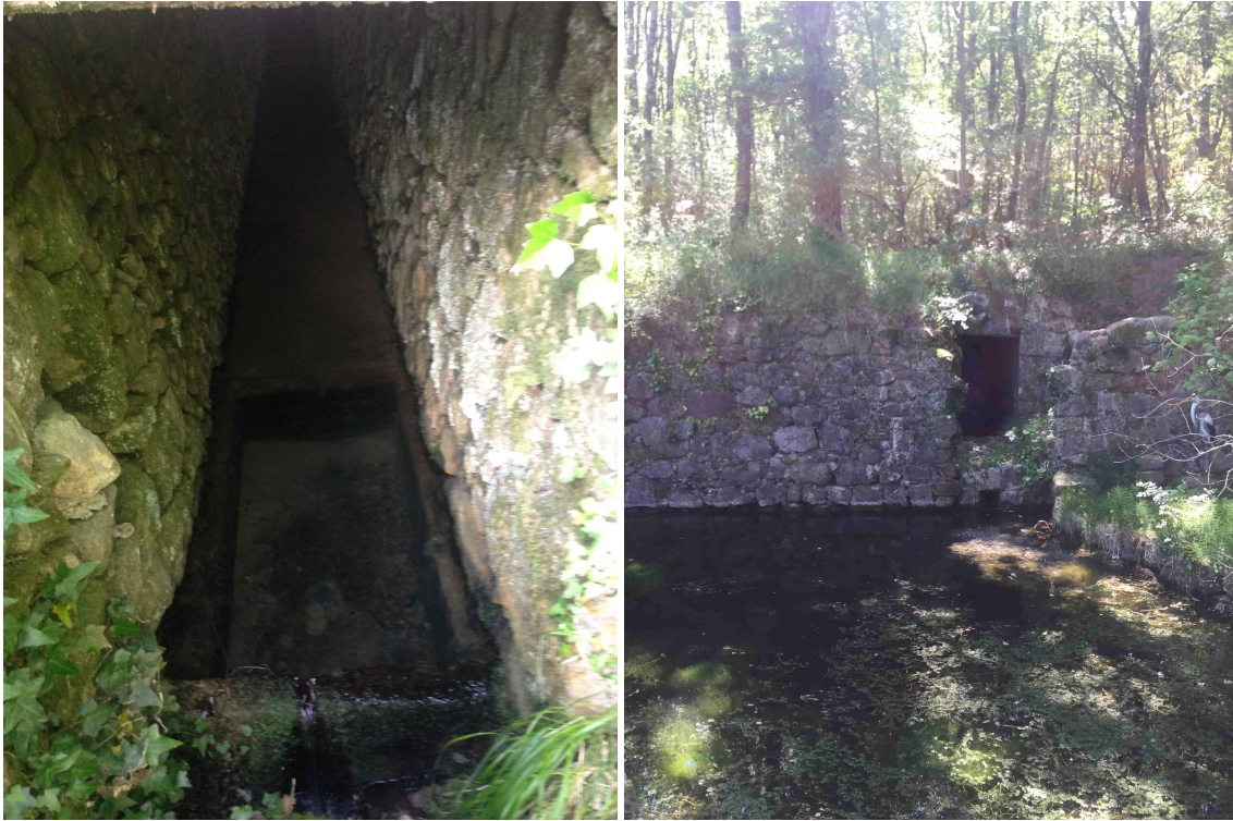
(a) Galerie de la Mine à eau du Bijour.
