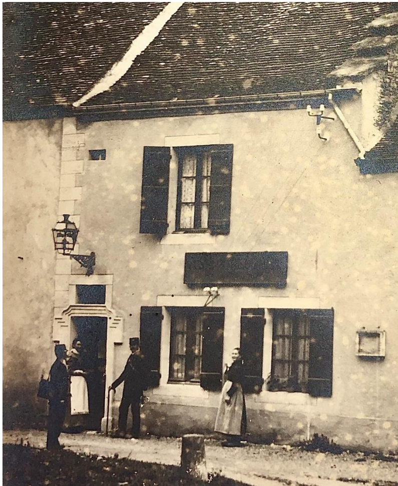
Figure 7 : lanterne du bureau de poste d'Arlay en 1895.
