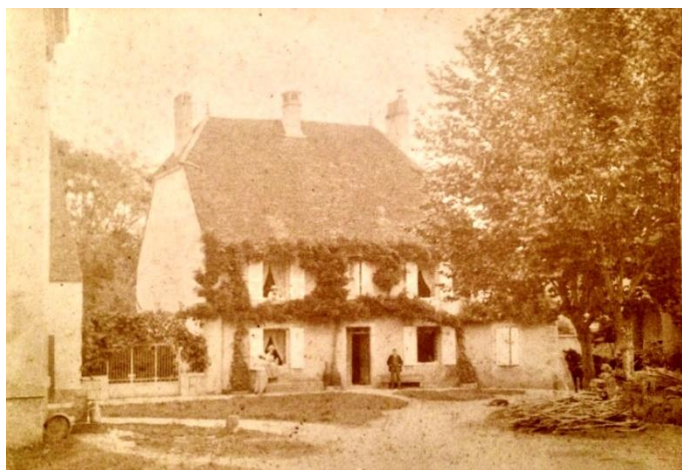
Figure 16 : photographie de la maison Vaudrit. Vers 1900, façade méridionale. Cliché amateur, auteur non identifié, 8x12 cm. Collection particulière.
