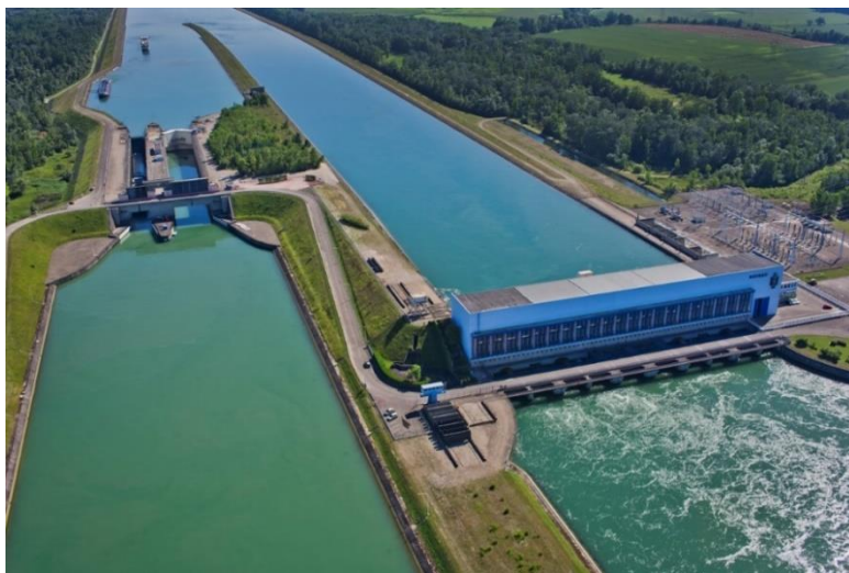
Figure 2-2. Centrale Rhinau sur le Rhin (Source : EDF)
