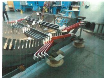
Figure 5-7. Montages des barres de stator (Velo, 1990)
