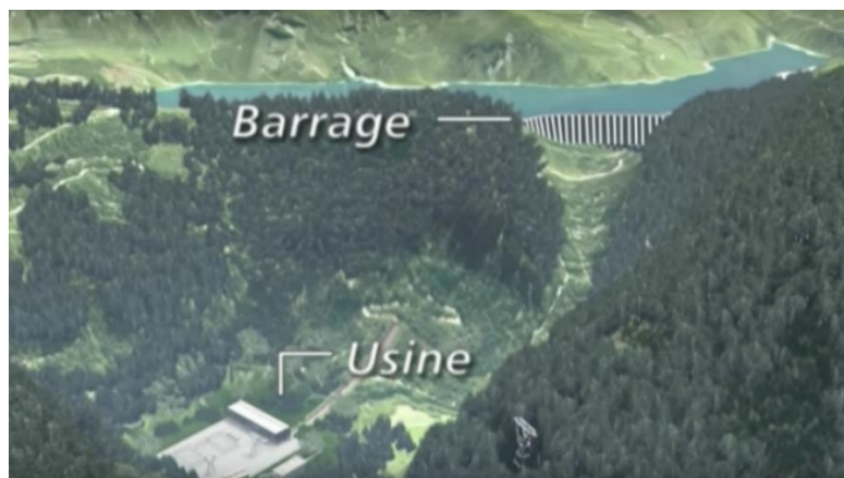
Figure 2-4. Exemple d'une centrale de lac (Source : EDF)
