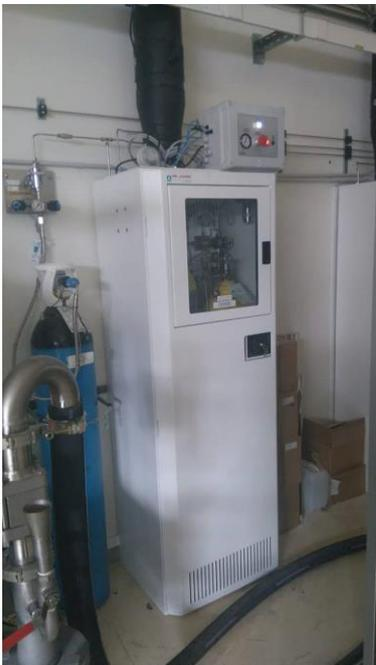
**Figure II.2: Type d'armoire étanche et sécurisée contenant des gaz utilisés pour la formation des revêtements CVD**
