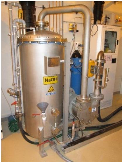
**Figure II.4 : Système de pompage (LRVP) et centrale de neutralisation permettant le traitement des produits de réaction.**
