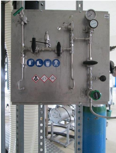
**Figure II.6 : Système de gestion du remplissage du réservoir de  $TiCl_{4(l)}$ .**
