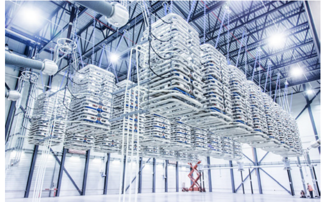
(b) ABB MMC (source : ABB)
