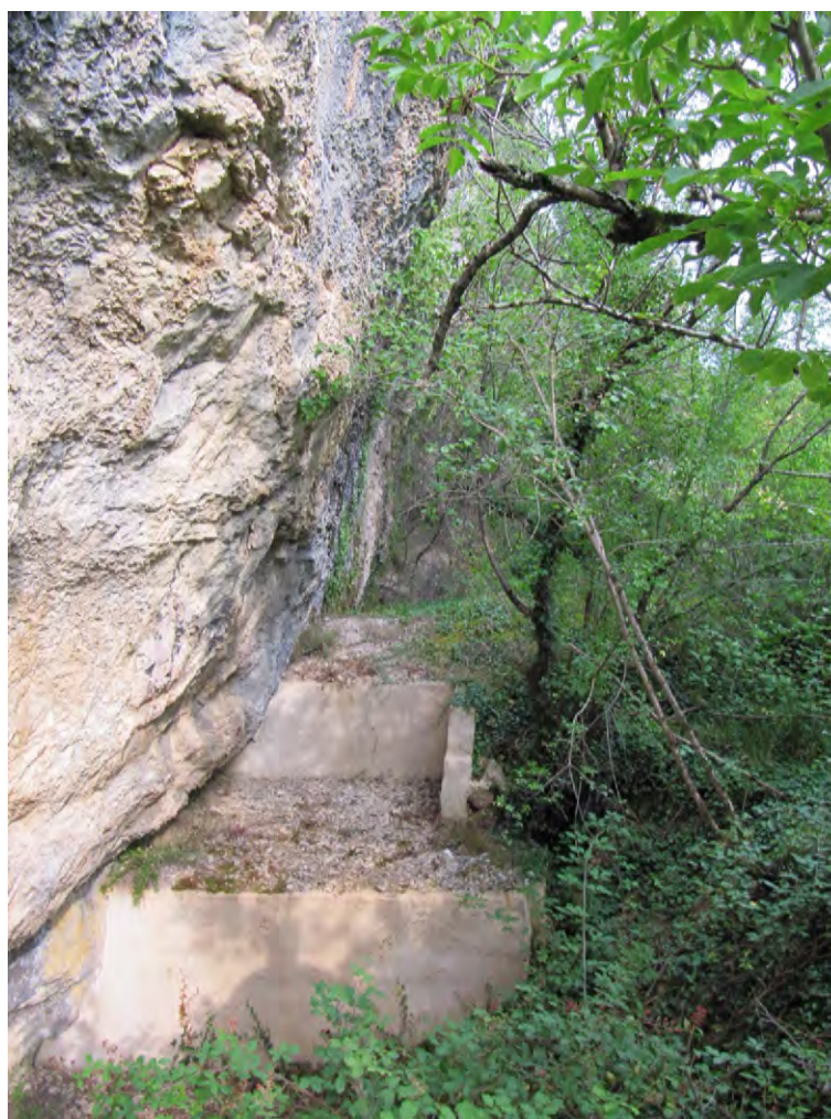
Figure 123 : Abri Murat. Vue du site actuel, 2017.
