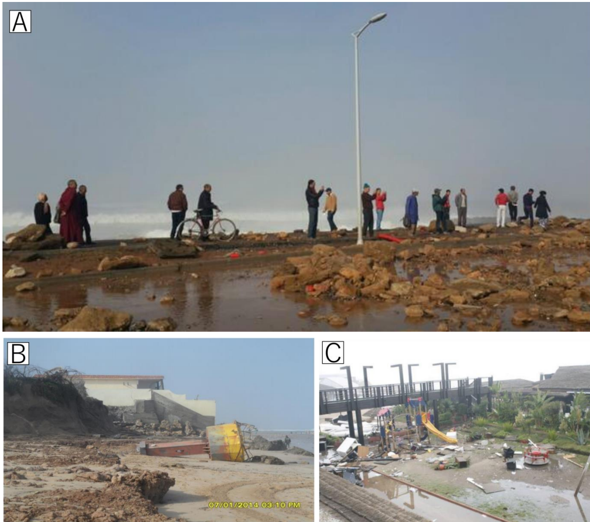
Figure II.6 - Aperçu des dégâts provoqués par la tempête de 2014 sur le littoral Atlantique Marocain. A : Bloc de boulders projetés par les vagues sur la route principale de Salé ( https://www.yabiladi.com/articles/details/22237/maroc-aussi-touche-vagues-deferlantes.html ). B : Bouée de signalisation déposée par la mer sur la plage de Mohammedia (ANP, 2014) ; C : Restaurant affecté par les vagues à Casablanca ( https://www.yabiladi.com/articles/details/22237/maroc-aussi-touche-vagues-deferlantes.html ).
